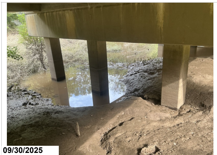
Bent 2 piles 1&2 local scour CS2
